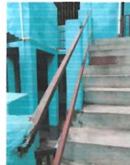
FOTO 4: MANTENIMIENTO DE BARANDAS
